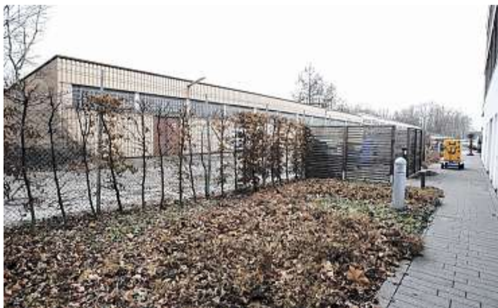
Die Lagerhallen auf dem Gelände der Huckelrieder Kaserne sollen abgerissen werden und Platz machen für Wohncontainer.
